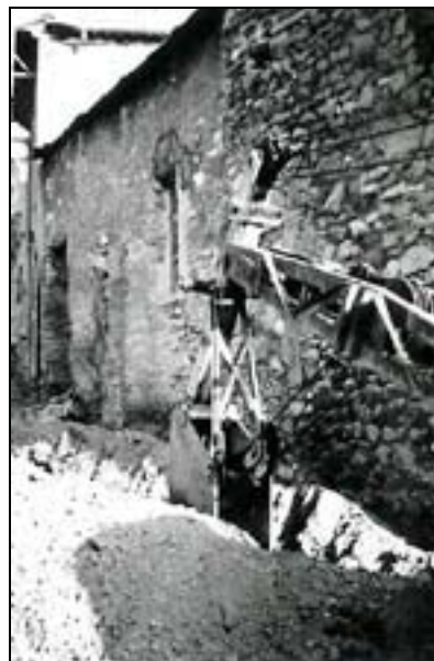
La rue de l'Église. Travaux pour l'adduction d'eau en 1958.
