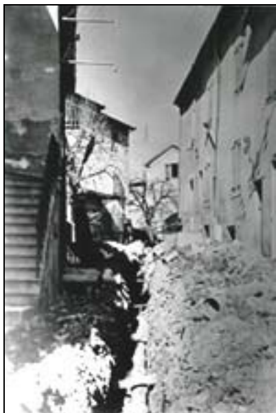
La Grand'rue. Devant le bar Audibert. Travaux pour l'adduction d'eau et égout en 1958.
