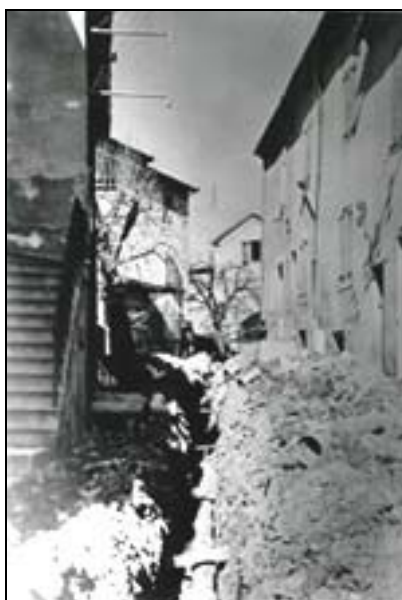
La Grand'rue. Devant le bar Audibert. Travaux pour l'adduction d'eau et égout en 1958.
