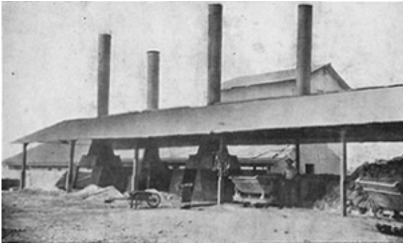
BATTERIE DE FOUR 1922 - Cheminées à cône plongeant. Nota - En 1921, les fours étaient sans cheminée et sans auvent.
