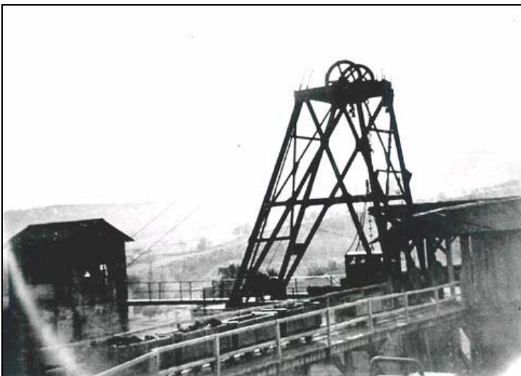
Vue des structures supérieures de la mine :
