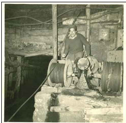
Bellacène Ahmed (dit le marocain) à la montée du plan tracte un convoi de wagons de charbon à l'aide d'un treuil.
