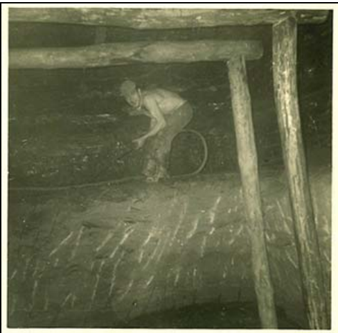
Gaii-Checa Roger en haut de la taille s'affaire avec un lourd marteau piqueur afin d'abattre des plaques de charbon.
