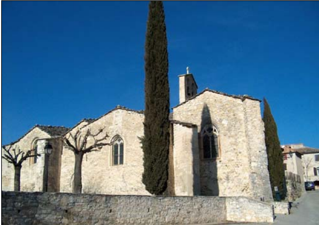
Vue de l'église côté Sud. Janvier 2005.
