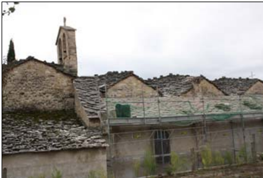
Le toit côté nord en cours de rénovation.
