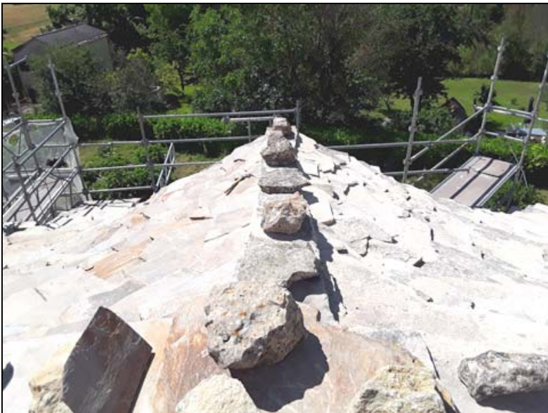
Une partie angulaire du toit.
