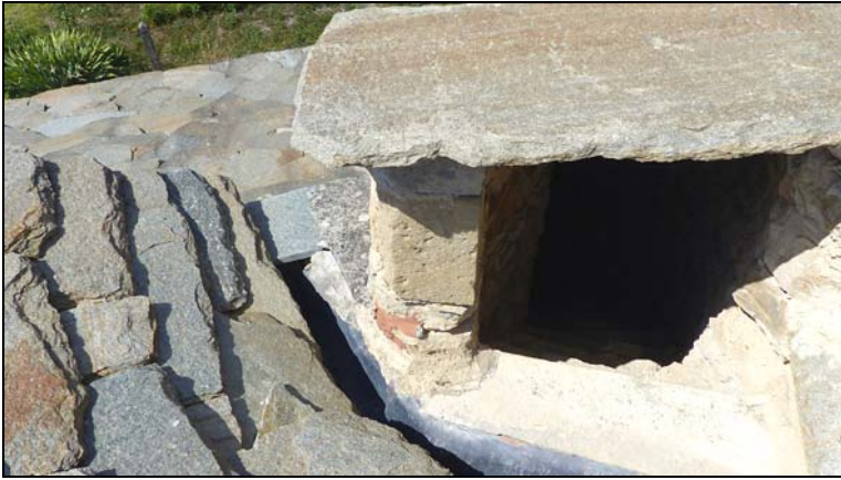
Trappe par laquelle on passe pour quitter le toit pour rejoindre l'escalier intérieur.
