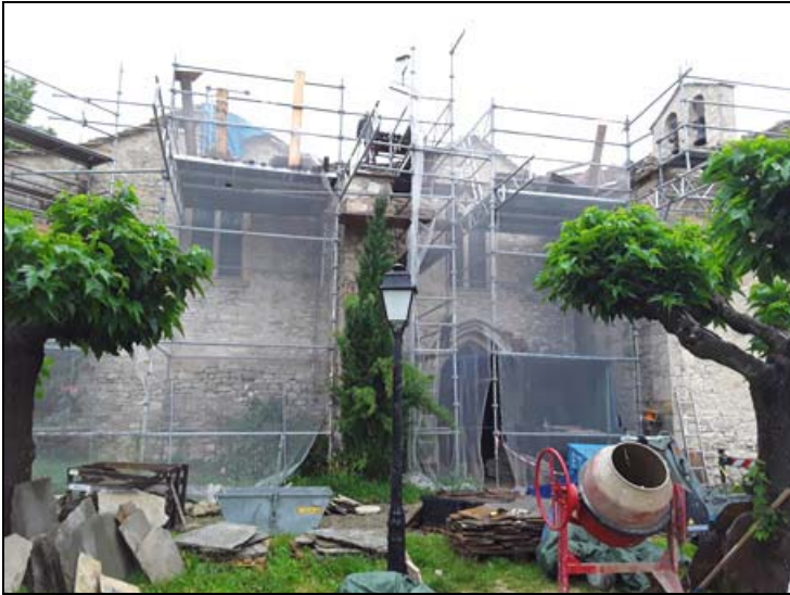
Échafaudage ceinturant la façade sud pendant les travaux.
