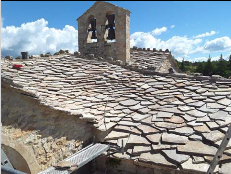
Une partie du toit refait avant le nettoyage de fin de chantier.
