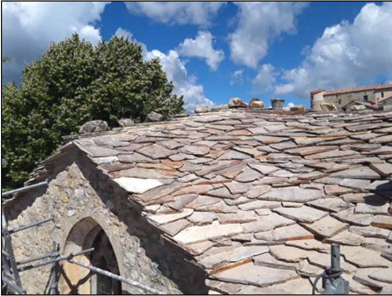
Une portion du toit refait.
