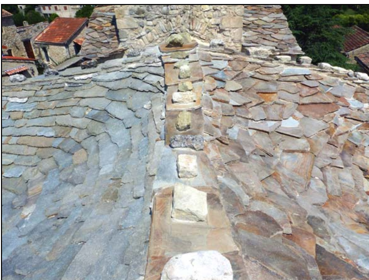
Une autre vue de la toiture côté nord et côté sud.
