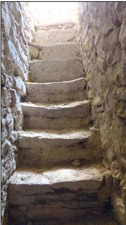
Escalier qui part de la sacristie pour accéder au toit en lauzes.
