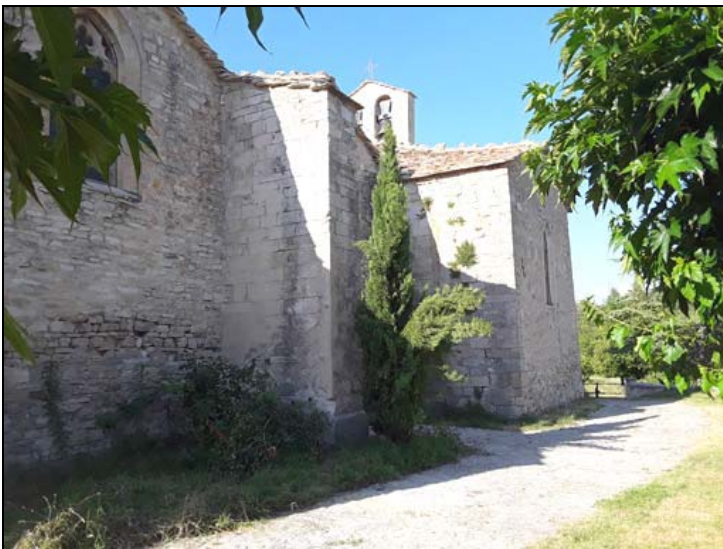
Partie droite de la face sud de l'église.
