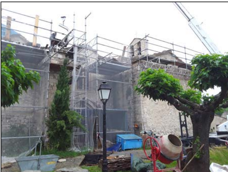
Vue du chantier et de sa grue en action.
