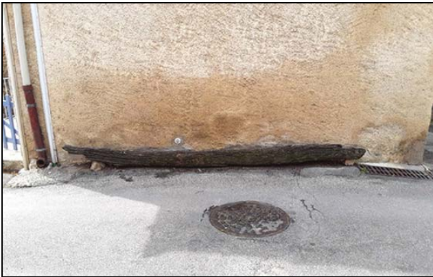
La poutre qui a servi de banc durant tant d'années.
