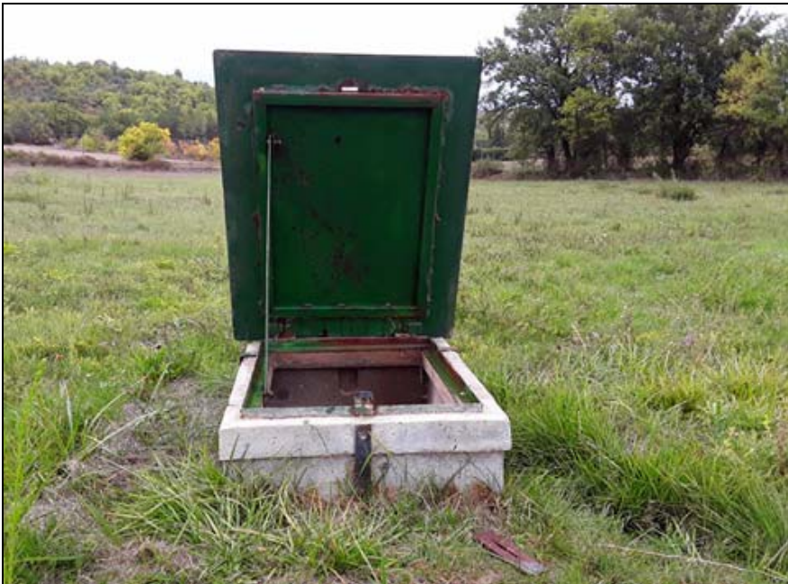
Arrivée de l'eau de source dans ce regard. (regard N°1).
